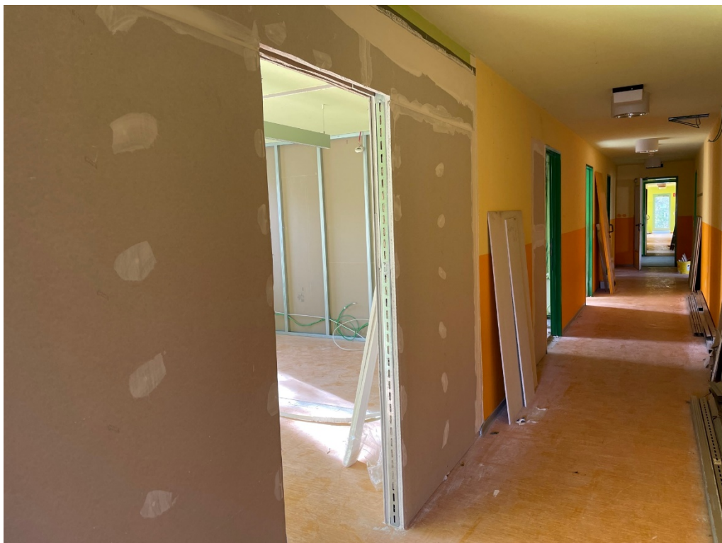
Neue Wände wurden eingezogen
