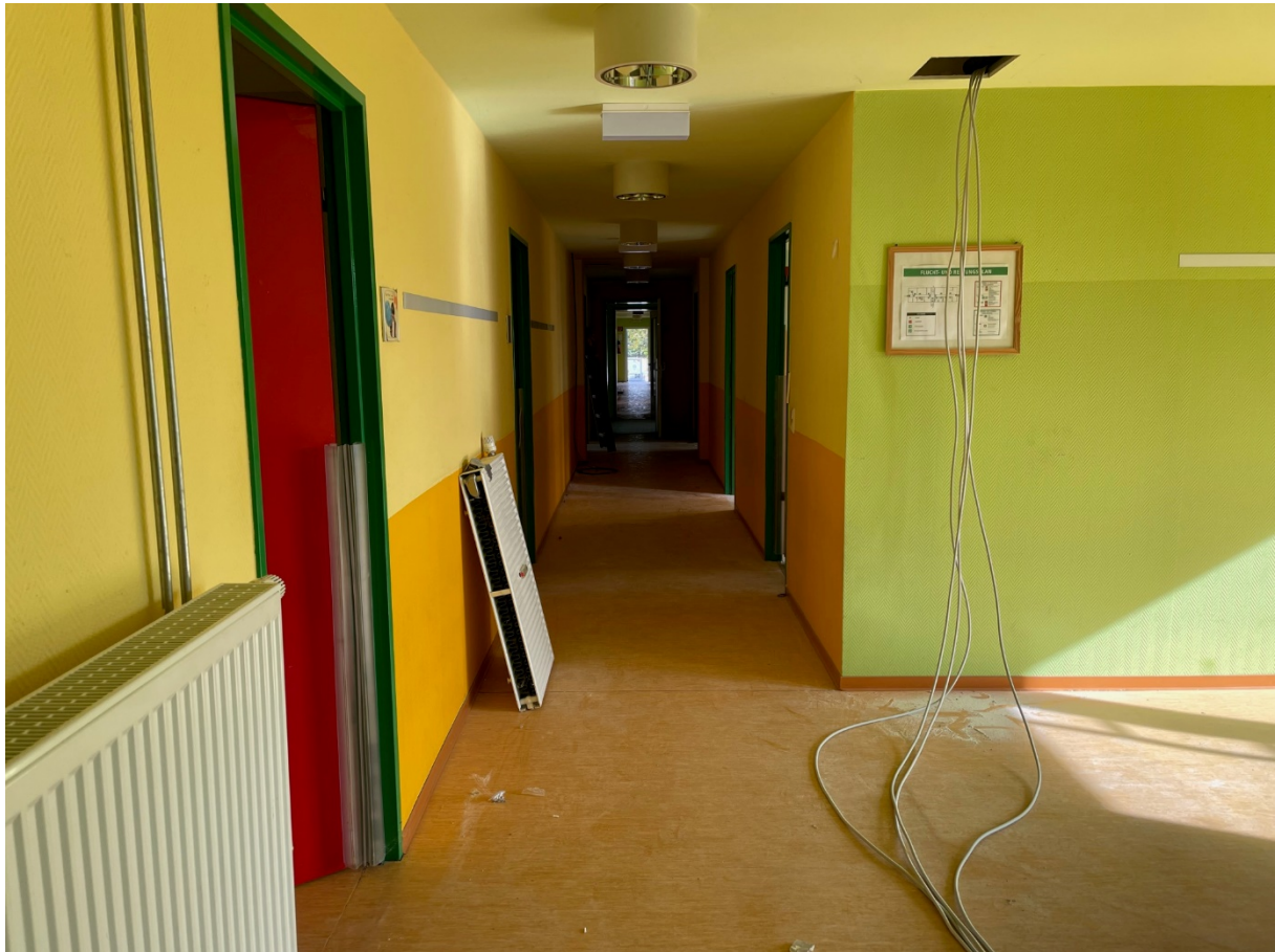
Überall sieht man die Spuren der Handwerker
