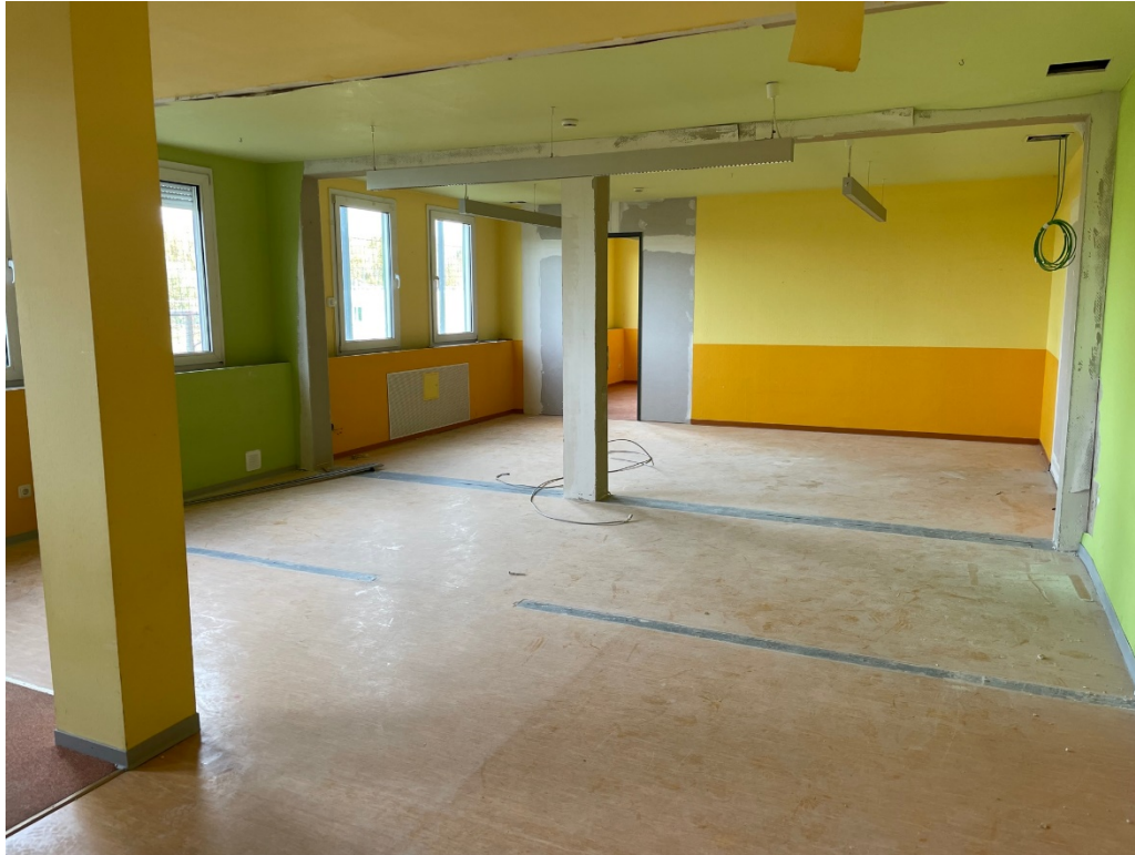
Große Räume sind am Entstehen
